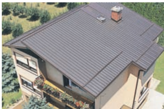
Trapezni profil s 3 cm izolacije iz poliuretana
