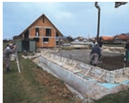
Betonaža temeljne plošče.
