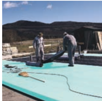
Polaganje hidroizolacije na prvi sloj toplotne izolacije FIBRANxps 400-L pod temeljno ploščo pritlične stavbe
