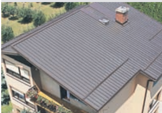
Trapezni profil s 3 cm izolacije iz poliuretana
