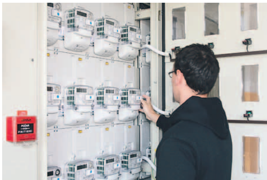
V Domplanovem večstanovanjskem objektu v Struževem je vgrajenih kar 245 števecov, ki stanovalcem omogočajo sprotno merjenje porabe energentov in posledično njihovo smotno porabo.
