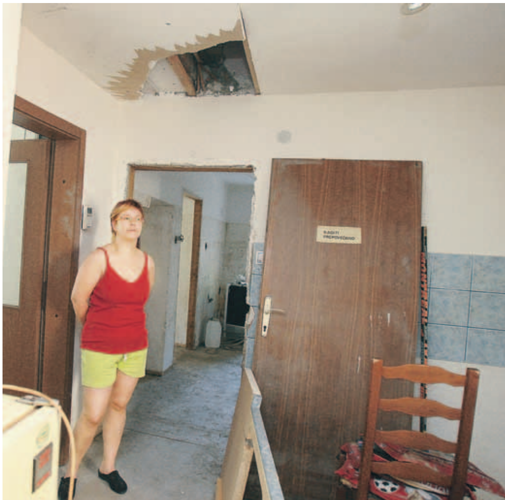
"Pritličja nima smisla več urejati. Po letu 1990 nas je poplavljal na tri leta," je povedala Barbara Benedičič, ki se je 18. septembra lani iz poplavljenega stanovanja rešila tako, da je prebila strop in skozi luknjo zlezla v zgornje nadstropje.
