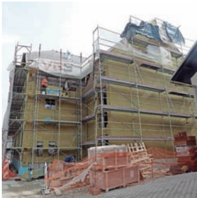
Gradnja Hiše generacij poteka po načrtih. / FOTO: JURE FERLAN
