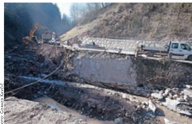
Na Fužinah se je že začela gradnja novega mostu.
