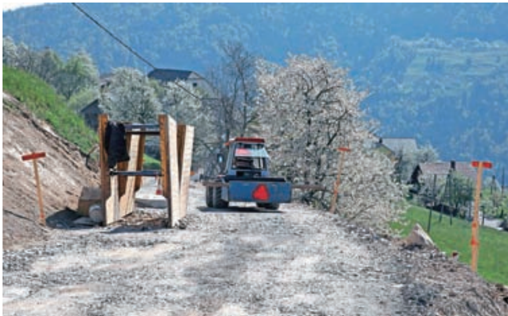
Na odseku Murave–Žetina poteka sanacija štirih globokih plazov. / FOTO: GORAZD KAVČIČ
