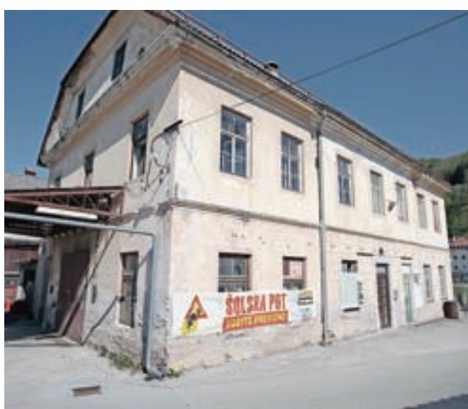
Staro šolo naj bi po obnovi namenili za izvajanje dnevnega varstva in začasno namestitev starejših. / FOTO: GORAZD KAVČIČ
