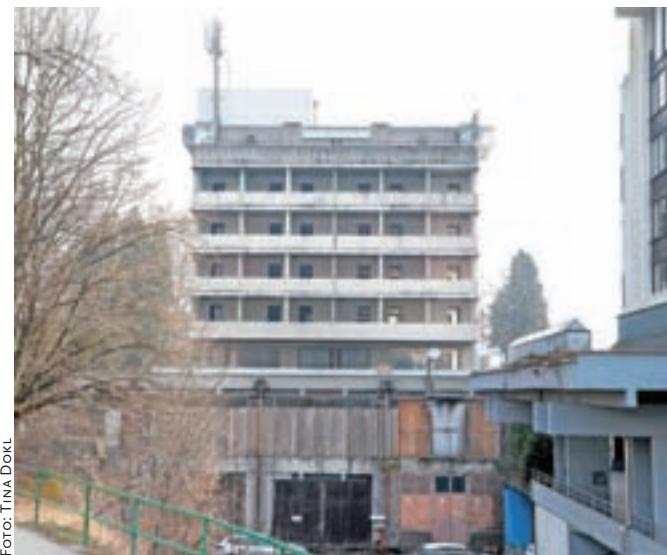
Prvi gradbeni posegi na hotelskem objektu so se že začeli.
