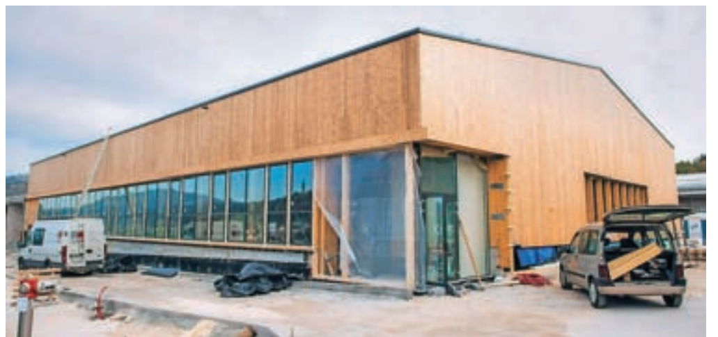
Ob osnovni šoli v Gorenji vasi končujejo gradnjo športne dvorane. / FOTO: TINA DOKL
