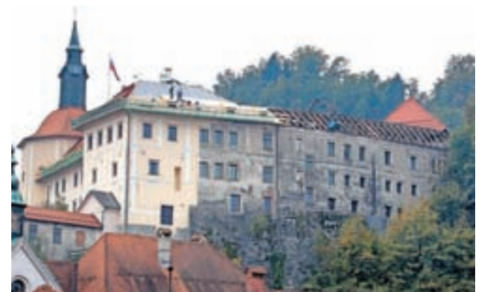
V minulih mesecih je potekala celovita obnova strehe Loškega gradu. / FOTO: TINA DOKL
