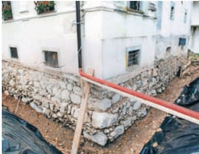
Izbrani izvajalec je v teh dneh že začel graditi zunanjo meteorno kanalizacijo ob objektu s hidroizolacijo.
