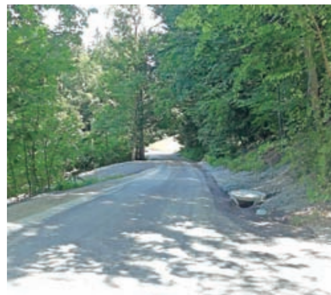
Obnovljeni odsek na cesti proti Blegošu / FOTO: ARHIV OBČINE
