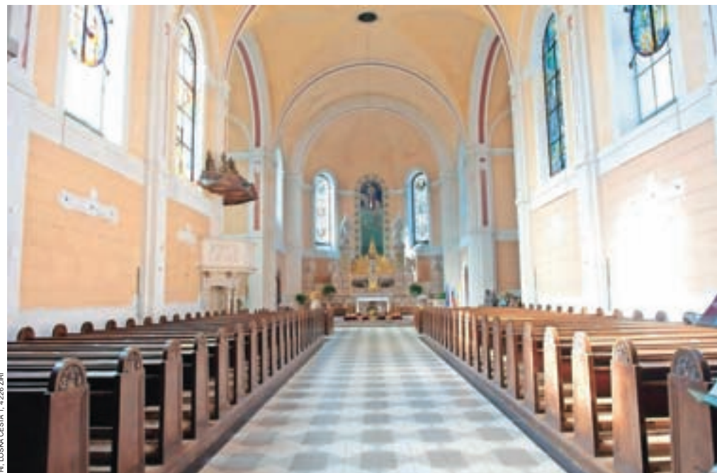
V začetku marca so končali prvi del obnove župnijske cerkve sv. Martina v Žireh.
