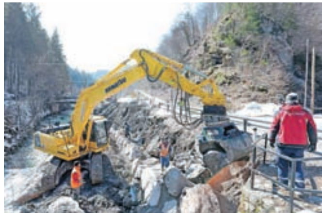
Za potrebe rekonstrukcije križišča v Podroštu ta čas gradijo podporne zidove v strugi Selške Sore. / FOTO: TINA DOKL
