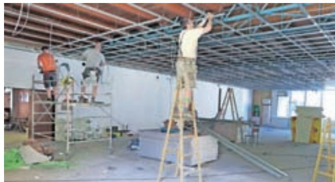
V jedilnici OŠ Železniki so zamenjali tudi dotrajano streho.
