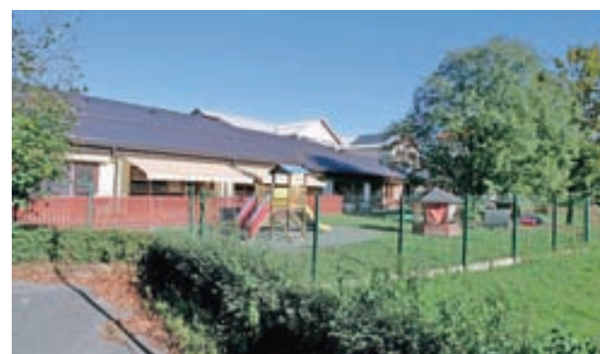
Vrtec so prek poletja energetske sanirali, dobil je tudi novo streho, saj je stara že zamakala. / FOTO: TINA DOKL
