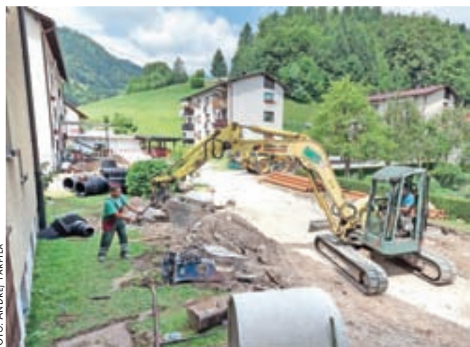
Na Kresu ta čas obnavljajo vodovod in kanalizacijo.
