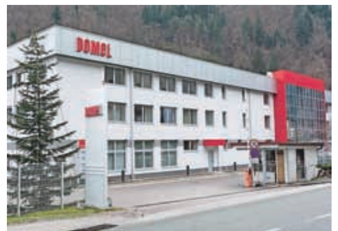
Domel je v prenovu poslovne stavbe vložil 1,1 milijona evrov. / FOTO: ANDREJ TARFILA
