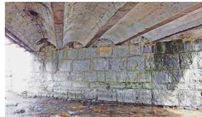
V Poljanah bodo celovito obnovili tudi most čez Ločivnico.
