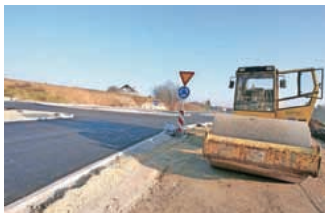
Sredi decembra so opravili večino gradbenih del na novem krožišču. / FOTO: TINA DOKL
