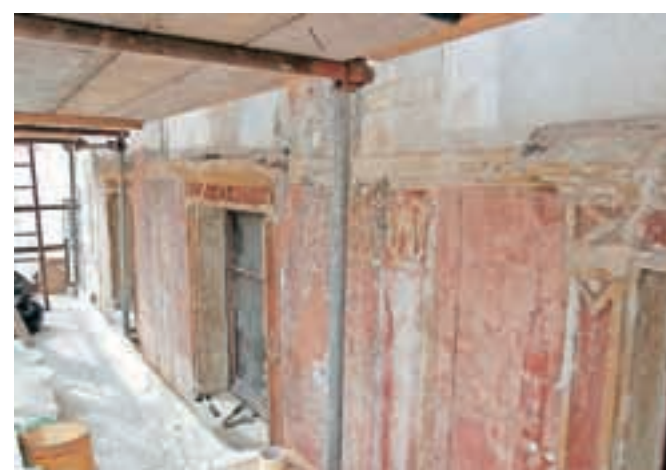
Stanje med deli – očiščena površina, odstranjena zunanja okna, domodeliranje kamnitih okvirjev, zapolnjevanje razpok in starih plomb na poslikavi ...
