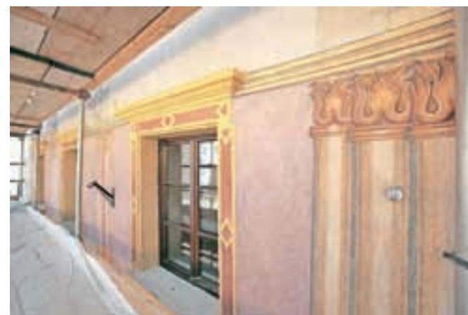
... in ob dokončanju. Na fasadi je delala ekipa konservatorjev-restavratorkov pod vodstvom mag. Ljubiše Milića in ekipa konservatorjev-restavratorkov za kamen pod vodstvom akademske restavratorki Saše Stržinar.
