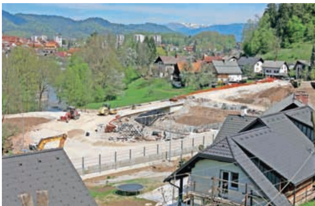
Gradnja poljanske obvoznice poteka brez večje medijske pozornosti. / FOTO: TINA DOKL
