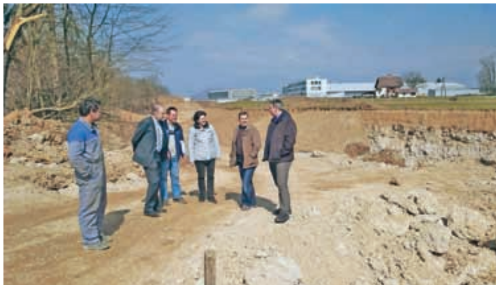
Pri ogledu gradbišča
