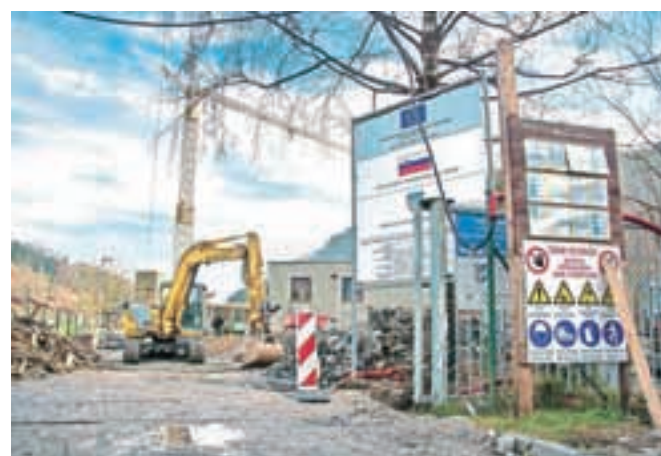
Dela na čistilni napravi v Studenem se končujejo.
