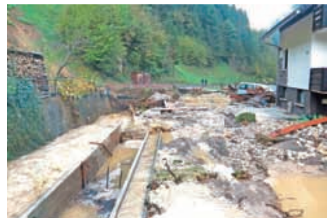
Škode na objektih in infrastrukturi je za okrog pet milijonov evrov. / FOTO: DENIS BOZOVIČAR
