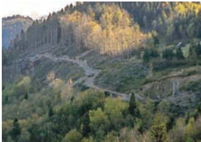
Pogled na del trase daljnovoda Železniki–Bohinjska Bistrica
