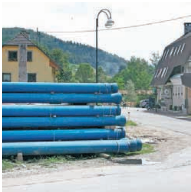
Zaradi gradnje vodovoda je na Trebiji in v Podgori vodo treba prekuhavati. / FOTO: GORAZD KAVČIČ
