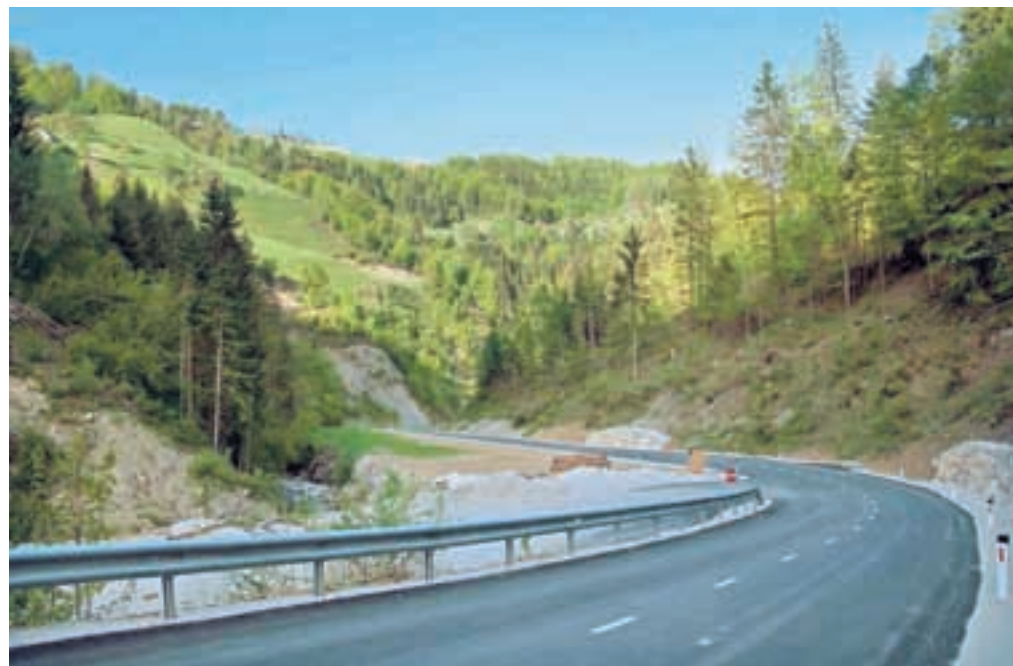
Lepo obnovljena cesta Zali Log–Davča /FOTO: ANDREJ TARFILA
