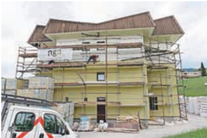
V zdravstvenem domu ta čas obnavljajo fasado in vgrajujejo dvigalo. / FOTO: DENIS BIZOVIČAR
