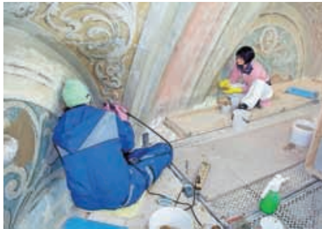
Restavratorji s posebnim kemijskim postopkom s poslikav odstranjujejo nečistoče, zatrdline in zasigane beleže.
