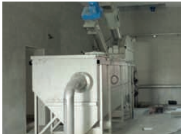
Mehansko predčiščenje v komunalni čistilni napravi Reteče.
