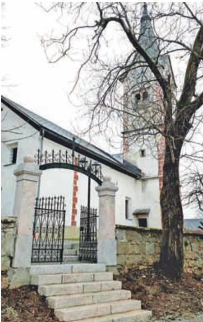
Sočasno z obnovo temeljev v cerkvi so obnovili tudi glavni vhod na pokopališče pri cerkvi. / FOTO: MATEJ RANT
