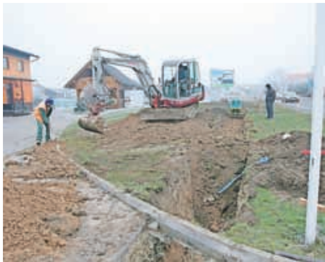
Na vzhodnem delu občine Škofja Loka so začeli graditi primarno vodovodno omrežje. / FOTO: TINA DOKL
