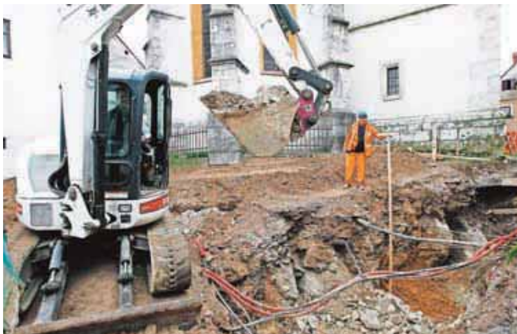
Obnovo Cankarjevega trga so začeli na klančinah od Spodnjega trga navzgor. / FOTO: GORAZD KAVČIČ
