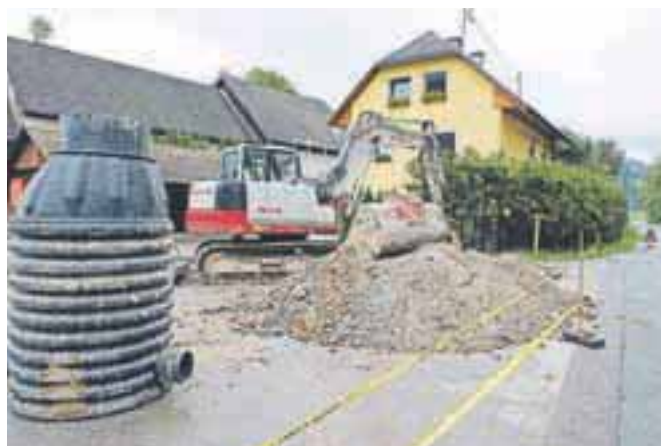
Gradnjo kanalizacije in vodovoda kljub evropski pomoči spremljajo visoki občinski stroški, zato je komunalni prispevek po novem nekoliko višji. /Foto: DENIS BOZOVIČAR
