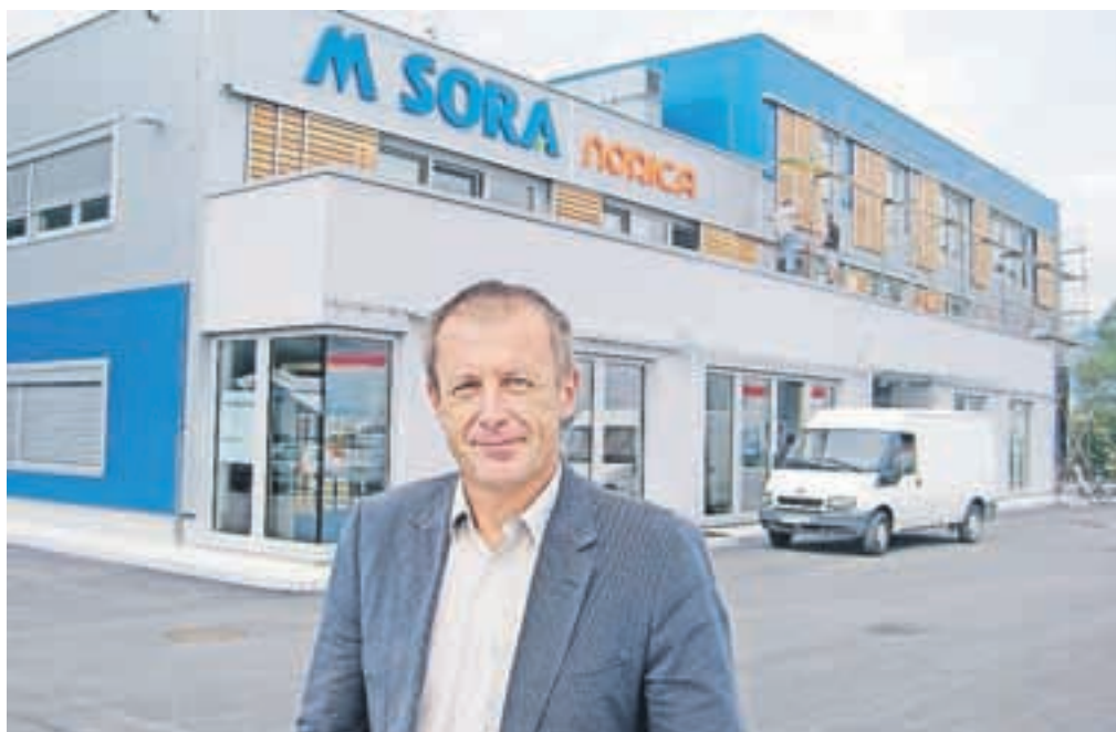
Aleš Dolenc pred novo stavbo M Sora v Žireh: »Pozitivni učinki združitve dejavnosti stavbnega okovja na enem mestu so že vidni.«
