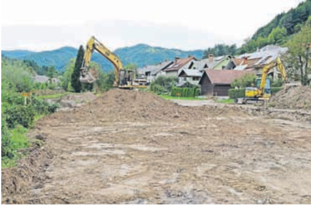
Gradnja obvoznice Gorenja vas se je začela. Obrisi, kje bo tekla, so sedaj že vidni.
