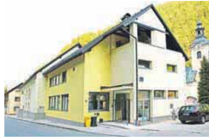
Obnova kulturnega doma je stala 600 tisoč evrov. / FOTO: ANDREJ TARFILA
