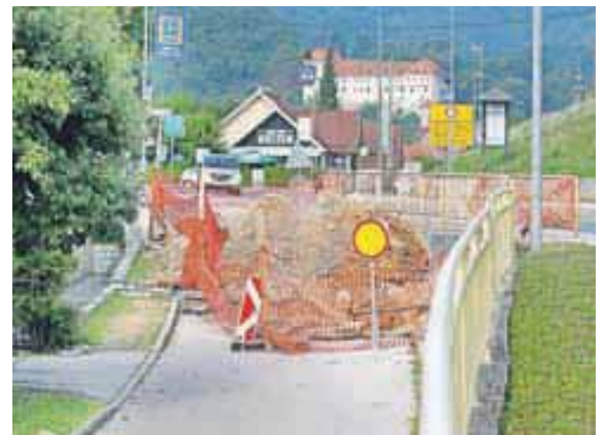
Stara Ljubljanska cesta je razkopana zaradi urejanja kanalizacije. / FOTO: TINA DOKL
