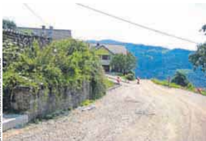
V vaseh pod Starim vrhom, kjer je občina gradila z evropsko pomočjo, je treba le še asfaltirati del ceste.
