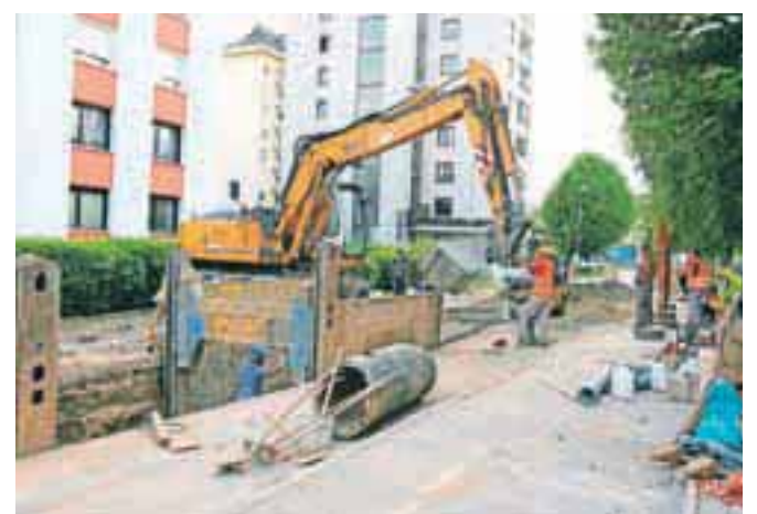
Gradnja kanala na Trati / FOTO: TINA DOKL
