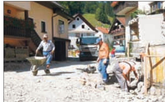
Do konca oktobra bo potekala obnova vaškega jedra v Selcih. / FOTO: GORAZD KAVČIČ
