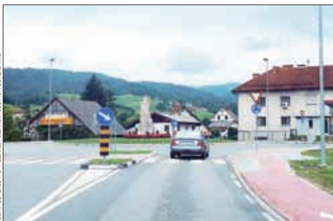
Krožišče v Gorenji vasi bi lahko začeli graditi čez leto dni. / FOTO: POLONA MLAKAR BALDASIN
