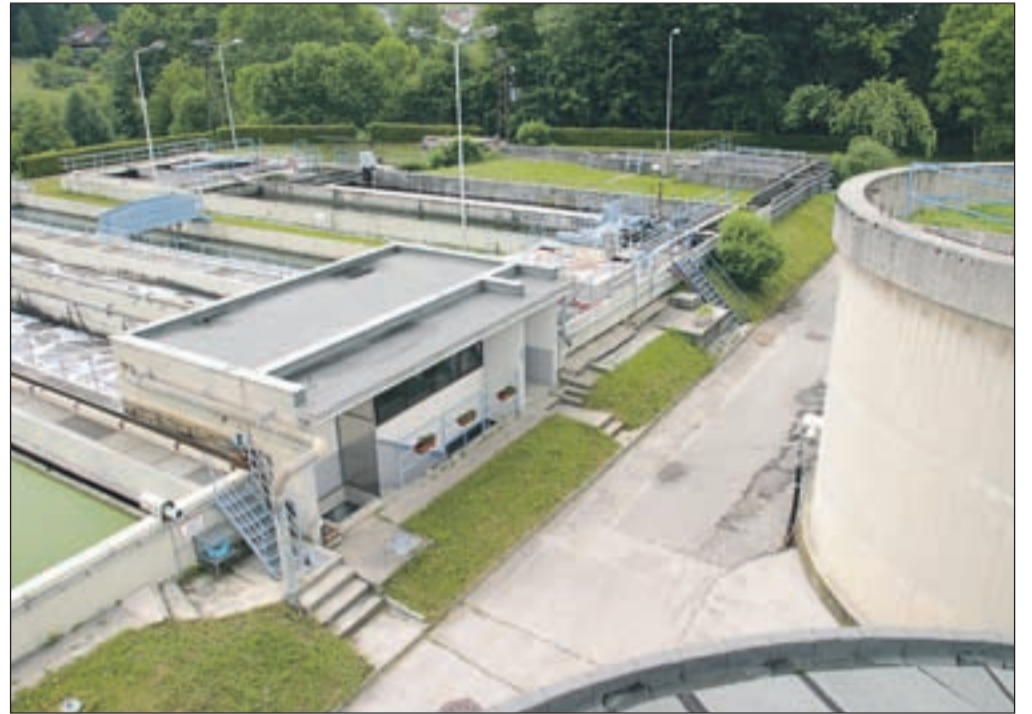
V projektu Ureditve porečja Sore bodo obnovili tudi osrednjo čistilno napravo v Škofji Loki.
