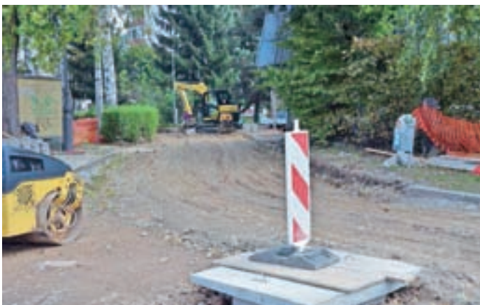
Pred začetkom izgradnje vrtca je treba urediti še komunalno infrastrukturo.
