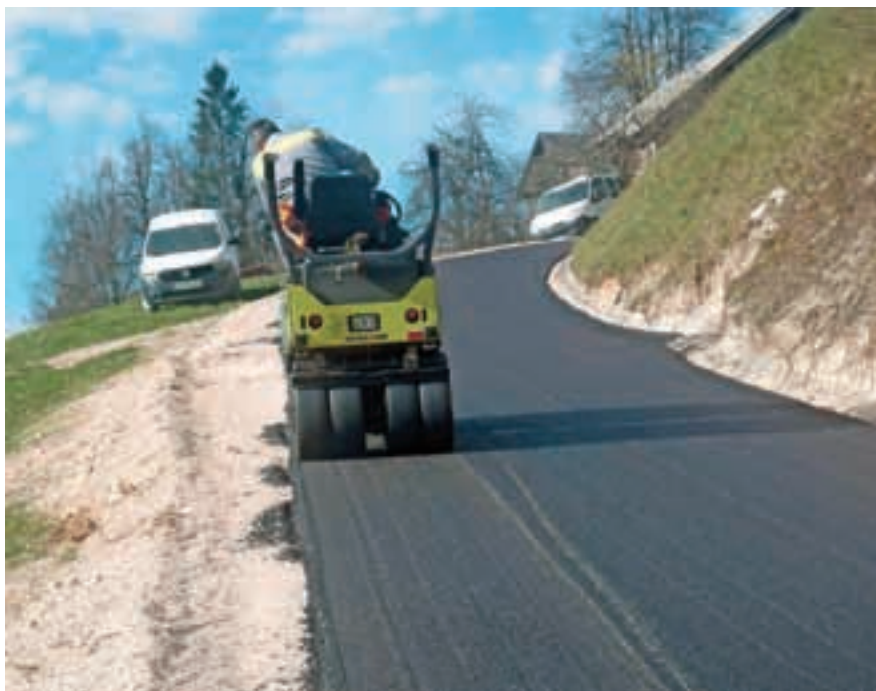
Asfaltiranje ceste proti Kozjeku
