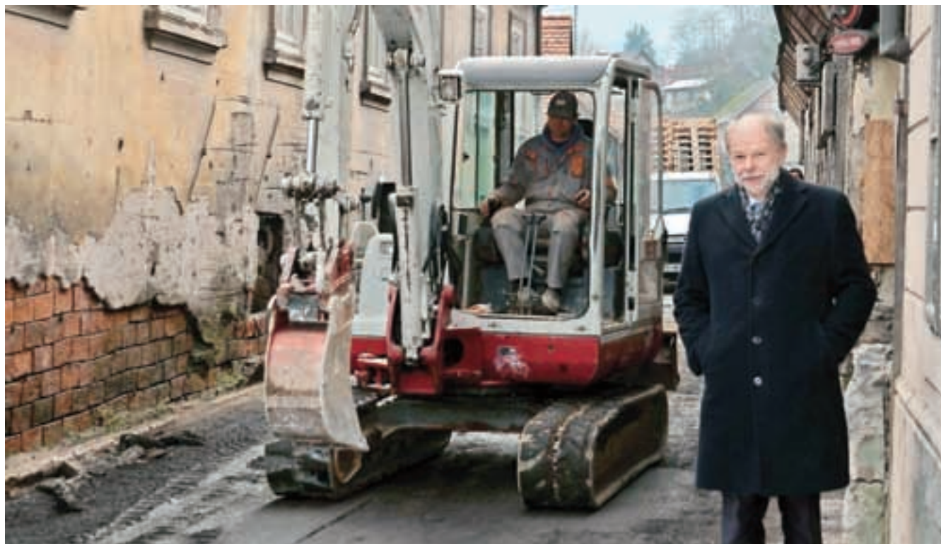
Velike priklopnike, ki so še nedavno ovirali promet na Poljanski cesti, so zamenjali gradbeni stroji, saj so se že v začetku decembra lotili najnujnejših popravil.
