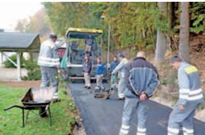
Med izvajanjem del
