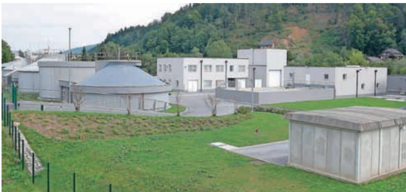
Projekt Ureditve porečja Sor se deli na dva dela, in sicer na ureditev kanalizacije in čistilni napravi ter na vodooskrbo. Na obeh delih so pridobili vsa uporabna dovoljenja. / Foto: Gorazd Kavčič
