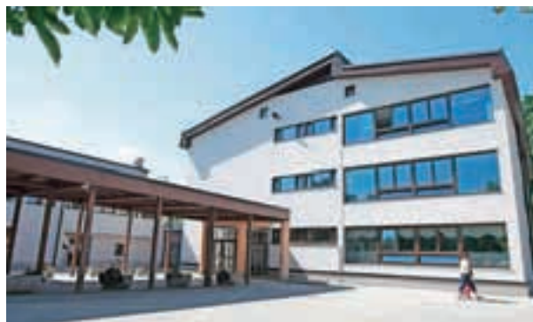
V energetske obnove Osnovne šole Cvetka Golarja na Trati so letos vložili več kot 450 tisoč evrov.
