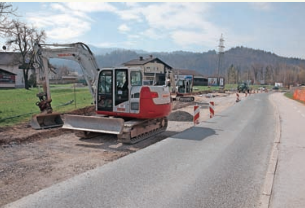
Rekonstrukcija Kidričeve ceste je velik gradbeni, organizacijski in finančni zalogaj.
