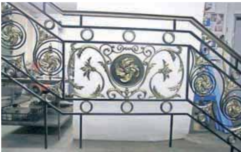
Za ornamente ograje je bilo potrebno izdelati modele iz lesa. / foto: arhiv Matija Hiršenfelder
