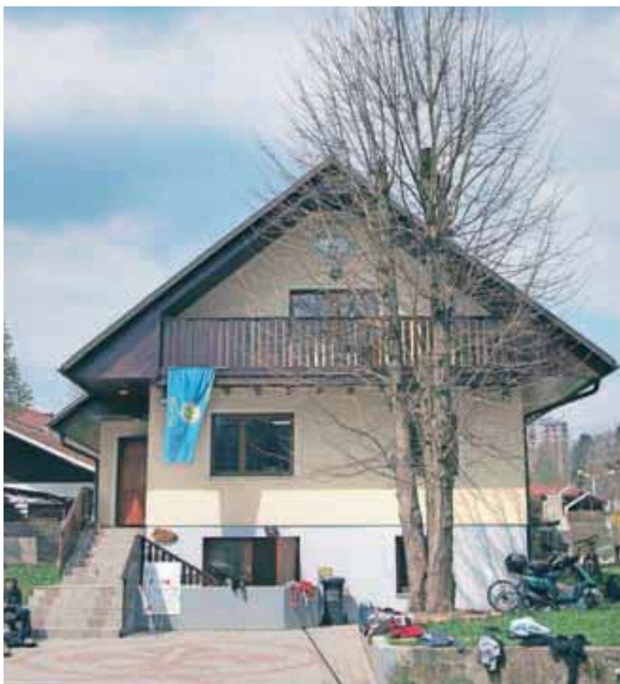
Loški taborniki so ponosni na svoj novi dom, ki so ga zgradili s prostovoljnim delom. / Foto: Jure Orehek
