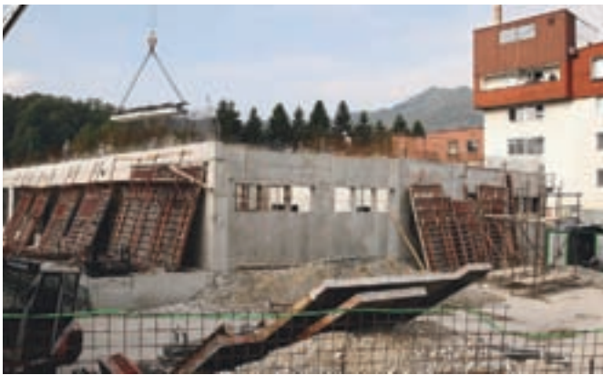
Gradnja Medpodjetniško izobraževalnega centra poteka po načrtih.
