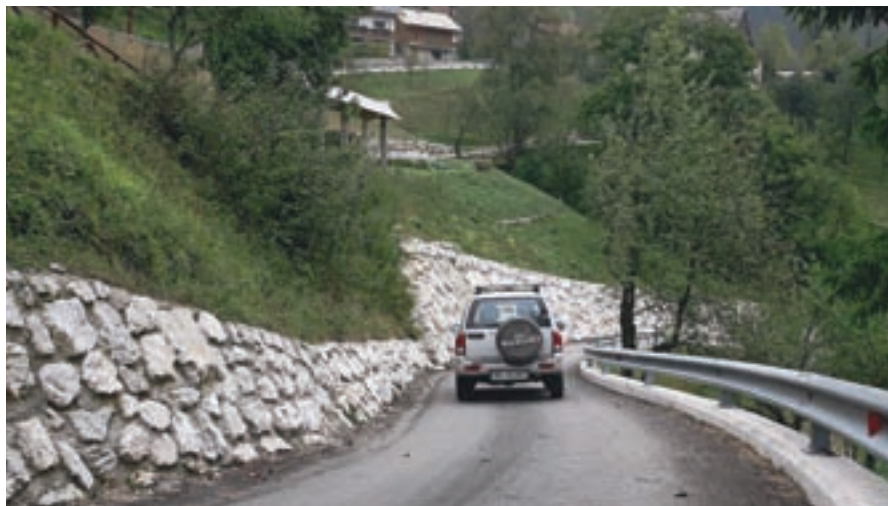
Domačini so veseli, da je sanacija plazu v Smolevi končana.
