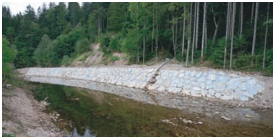
V Županovem kotu je zgrajen dolg in visok oporni zid, ki bo povečal poplavno varnost Sela.
