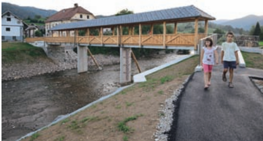
Gradnji vodovoda Podvrh-Zapreval se bo kmalu pridružila gradnja kanalizacije in čistilne naprave v Javorjah.
