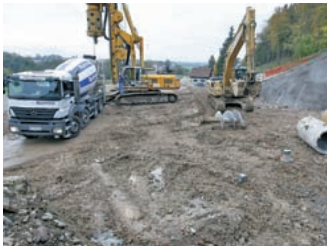
Gradnja poljanske obvoznice uspešno poteka. Na sliki: gradnja na puštalski strani
