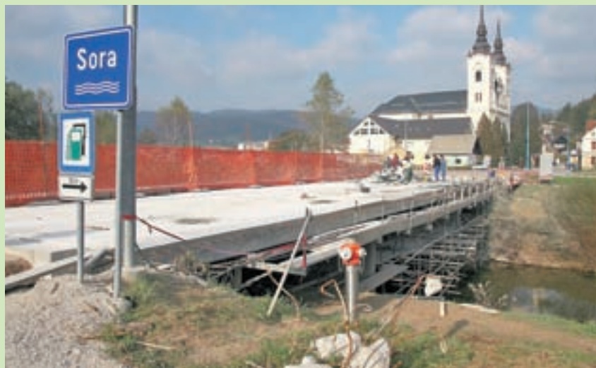
Obnova mostu bo državo stala 182 tisoč evrov, zapora prometa pa bo kar do konca leta.
