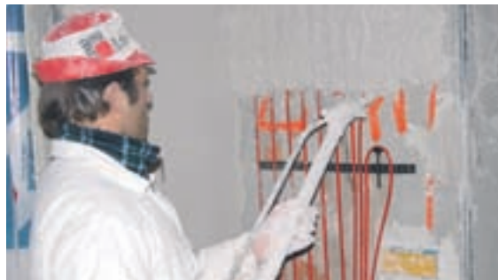
Ometavanje stenskega registra
