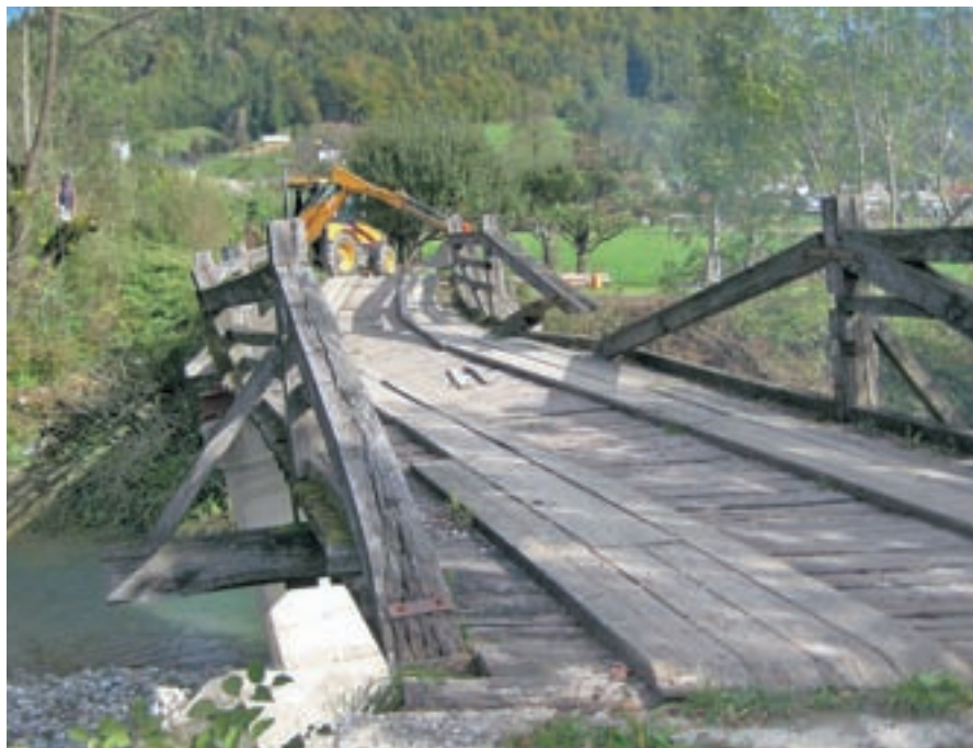
Obnova Starogoliškega mostu v Selcih
