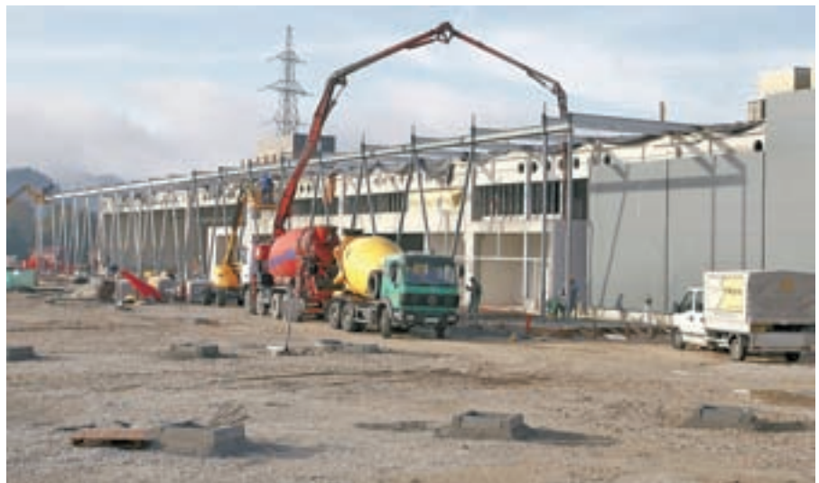
Gradbena in ureditvena dela v trgovski coni na Grencu so v zaključni fazi, trgovine pa še nekaj časa ne bodo odprte.
