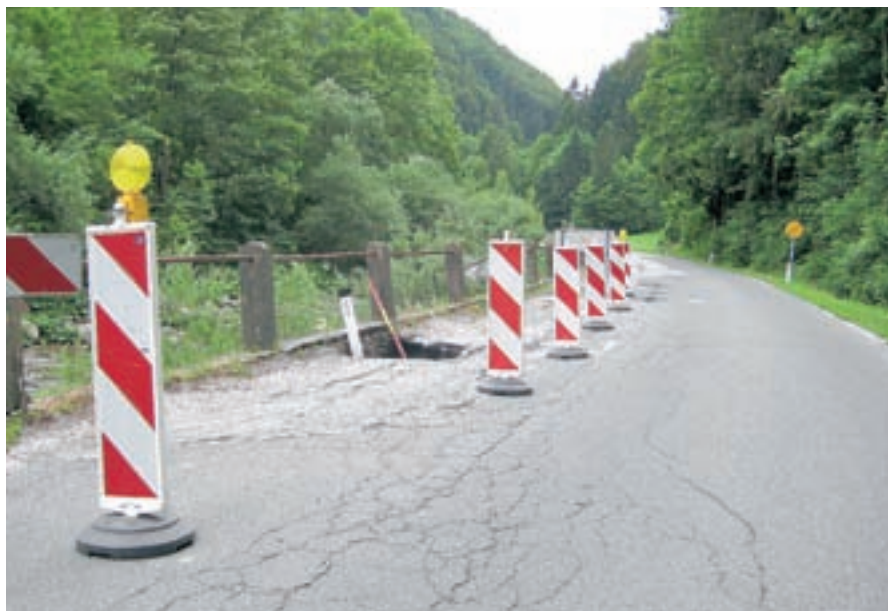
Večja dela pri rekonstrukciji ceste proti Sovodnju bodo izvedena v letih 2010 in 2011.
