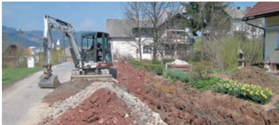
V Žireh bodo prihodnje leto gradili v sklopu evropskega projekta Urejanje porečja Sore.
