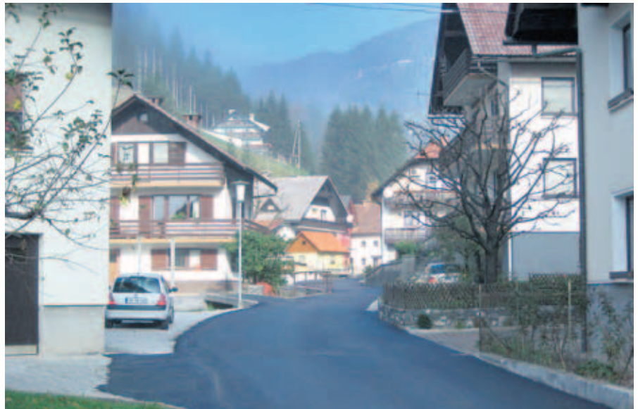
Na novo asfaltirane ceste so se razveselili tudi v Selcih.
