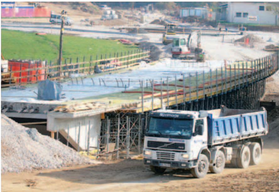
Prihodnja industrijska cona na Trati je največje gradbišče v občini, na sliki most čez Traški graben.
