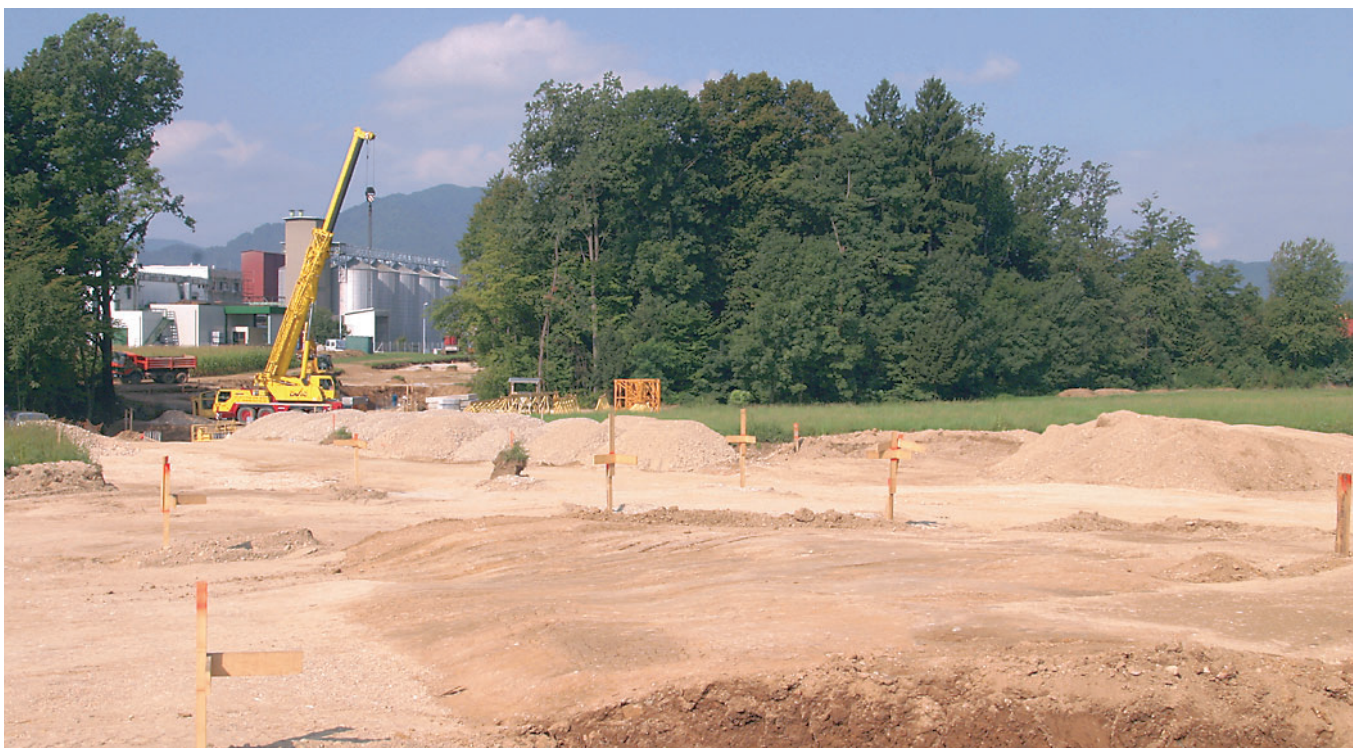
Gradijo že komunalno infrastrukturo za prihodnjo industrijsko cono.
