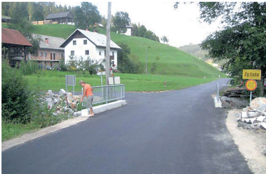
Obnovljeni most in cestni odsek v Zgornji Luši
