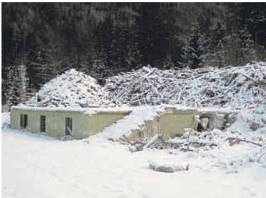
Porušen hotel Erika. Čez dve leti bodo zgradili novega.
