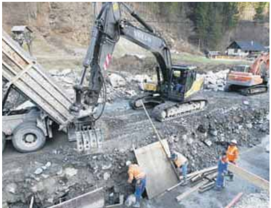
Začetek gradnje nove ceste v Davčo
