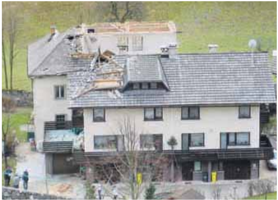
Močan veter je prevrnil ostrešje v Železnikih.
