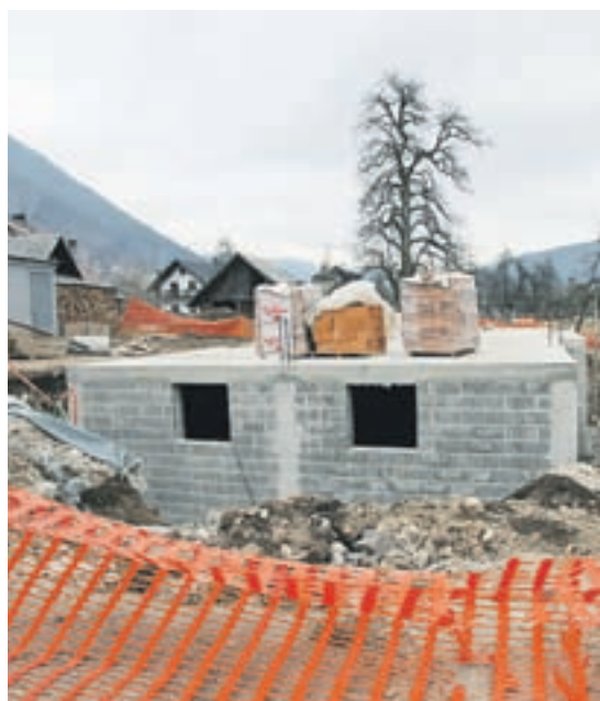
Gradbiše nove Bremčeve hiše
