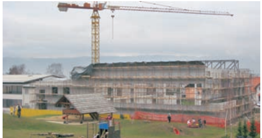
Gradnja večnamenske dvorane pri OŠ Žirovnica
