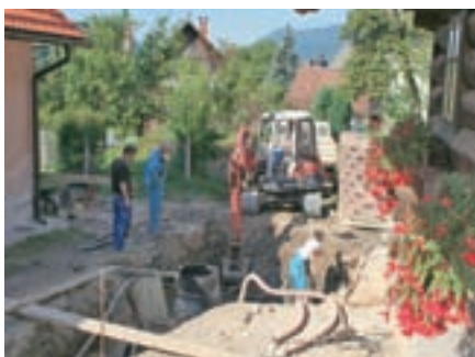
Letos so nadaljevali in končali gradnjo kanalizacije v Spodnjih Dupljah.
