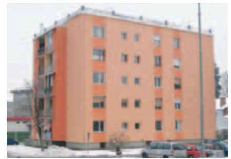
Obnova fasade stavbe na Nazorjevi 12 v Kranju
