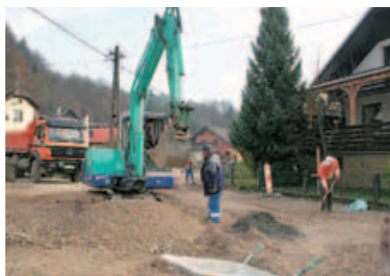
Jeseni so začeli graditi sekundarno kanalizacijo v Spodnjih Dupljah.
