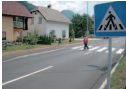
Od križišča v Žirovnici do zdravstvene postaje na Selu so obnovili cesto in zgradili pločnik.
