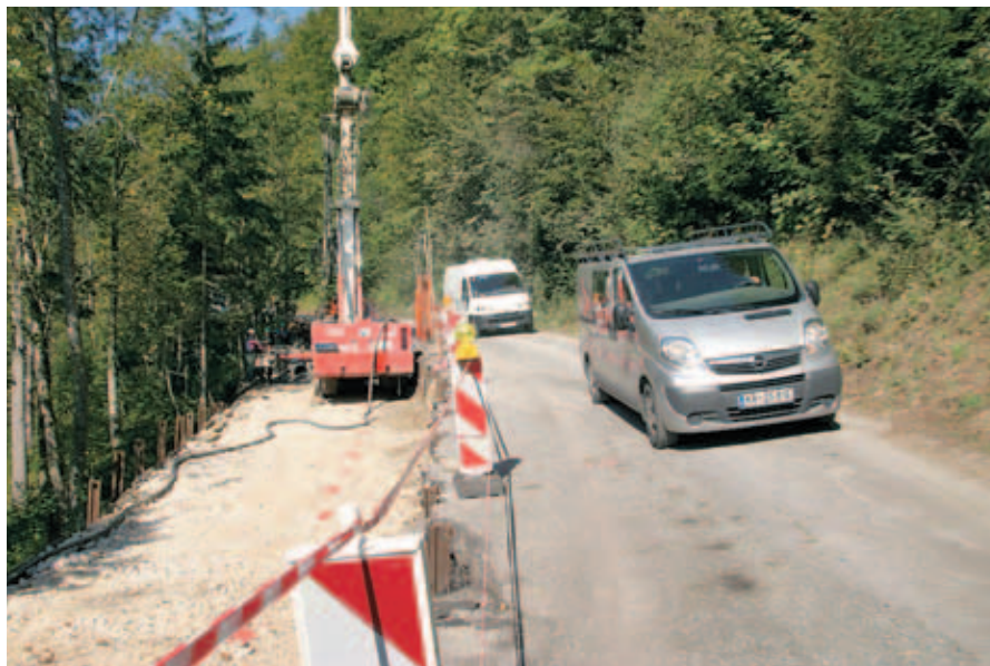
Uspešno so se lotili sanacije plazov na cesti Lenart-Luša proti Staremu vrhu.
