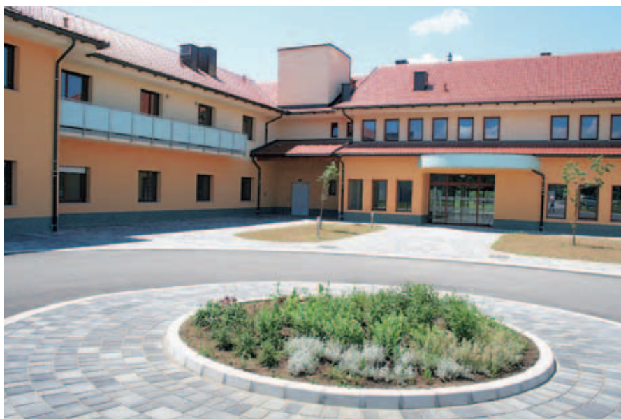
Dom za starejše občane je zgrajen, prvi stanovalci se bodo vselili januarja 2009.
