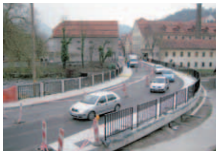
Jeseni so obnavljali Lahov most pri Šiširju.
