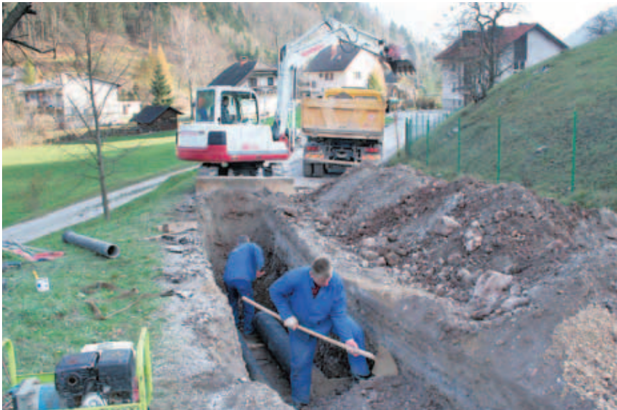
Jeseni so obnavljali vodovod v Podljubelju in cevovod proti Tržiču.
