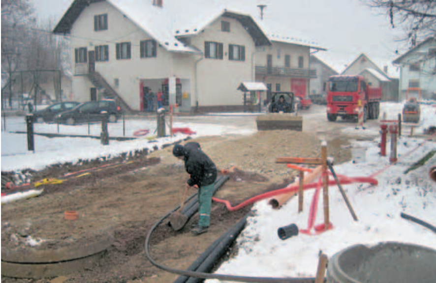
Kanalizacijo in vodovod bodo v Vogljah zgradili do septembra 2009.
