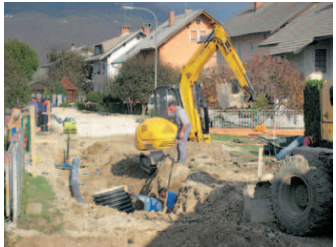
Gradnja kanalizacije in vodovoda v zahodnem delu Zgornjega Brnika
