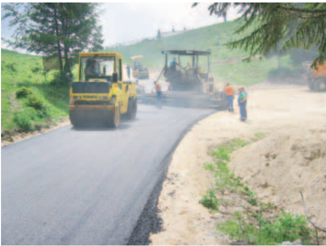
Asfaltiranje zadnjega odseka ceste na Jezercih
